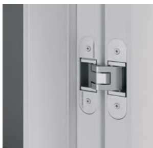
nový 3D závěs (otevřené dveře)
