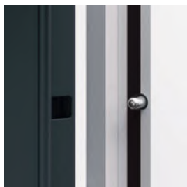
bezpečnostní trny proti vylomení – KWARC III
