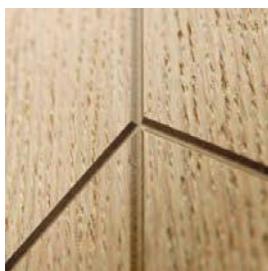
detail frézování - viditelná struktura přírodního dubu
